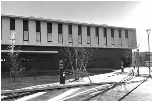
図2 美濃加茂市保健センター
