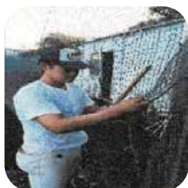
防御ネットの補修と管理
